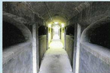
配水池の管理通路
