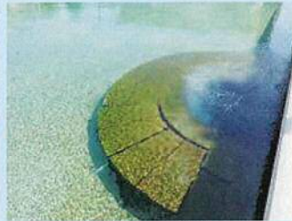
ろ過池への流入口
