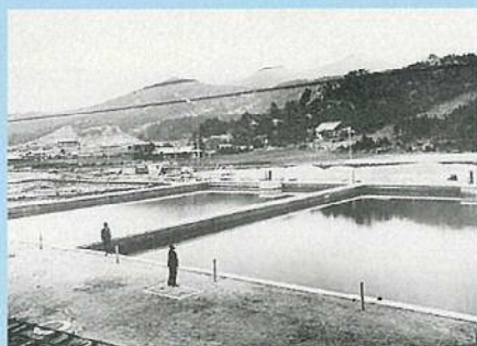
完成したろ過池
