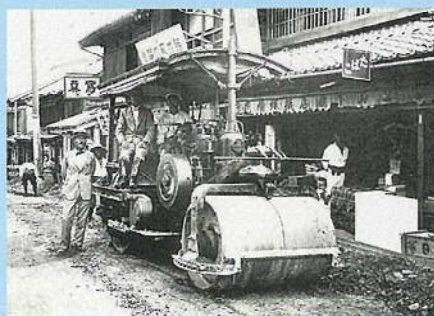
鉄管布設後の道路整備
