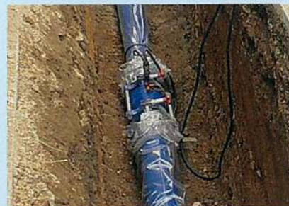
耐震管接合の様子
