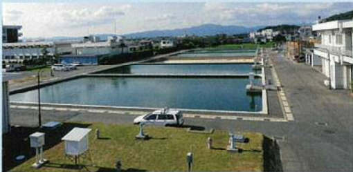
緩速ろ過池(流速1日4~5mのろ過を行う。)
